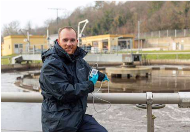
Sauerstoffmessung im Belebungsbecken einer Kläranlage
